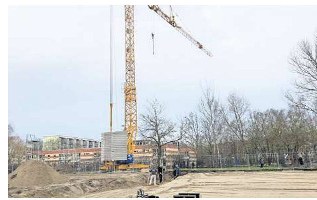
An der Loissiner Wende hat der Bau der Turnhalle der Martinschule begonnen.
